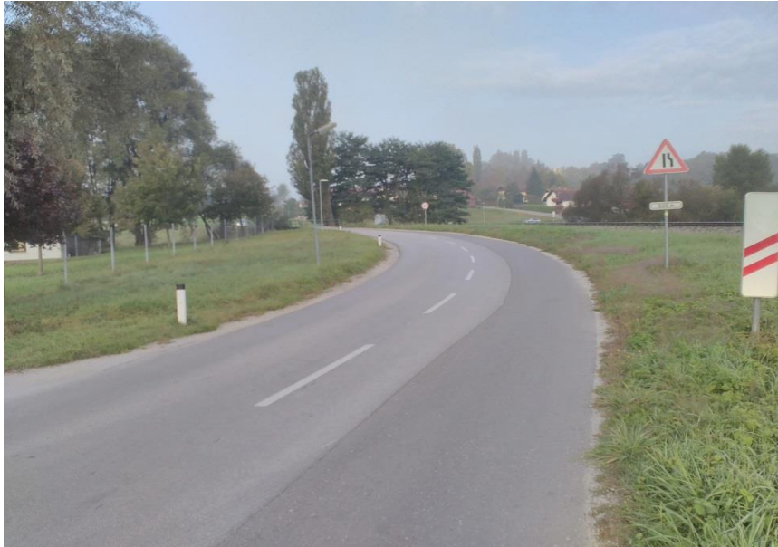
Slika 38: Manjkajoča povezava za pešce na Kolodvorski ulici
